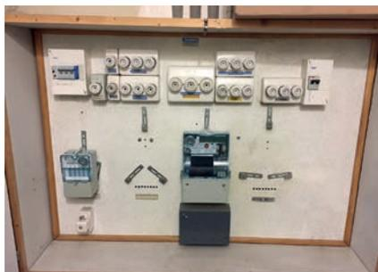
Elektrotabelleau mit schwachgebundenen LAP ausgekleidet
